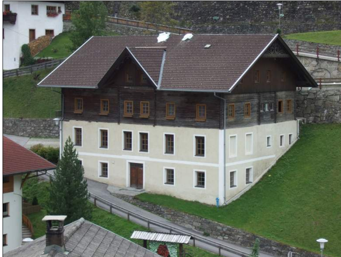
Schule Außervillgraten (c) OSG und Gemeinde Außervillgraten
